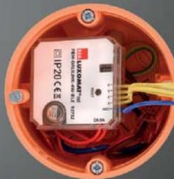
4. Соединение с 4-клавишным кнопочным выключателем
