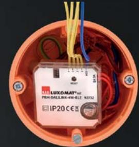
3. Встроенный интерфейс для кнопочных выключателей
